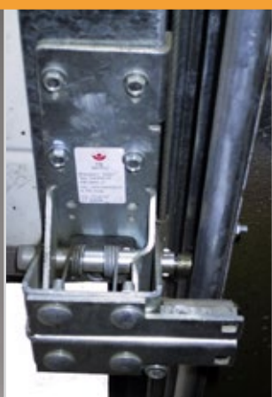
MZL – zabezpieczenie przed opadnięciem bramy w wypadku pęknięcia linek
