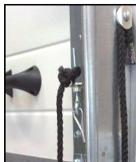
Rys. 1 Otwieranie ręczne (ciągnio sznurowe)
